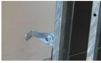
Montieren Sie die beiden Türriegel It. Abbildung. Zwischen Anschlag und Riegel ist eine Scheibe vorgesehen. Bei der hinteren Tür ziehen Sie die Stoppmutter nur so fest, dass der Türriegel sich noch leicht bewegen kann.
